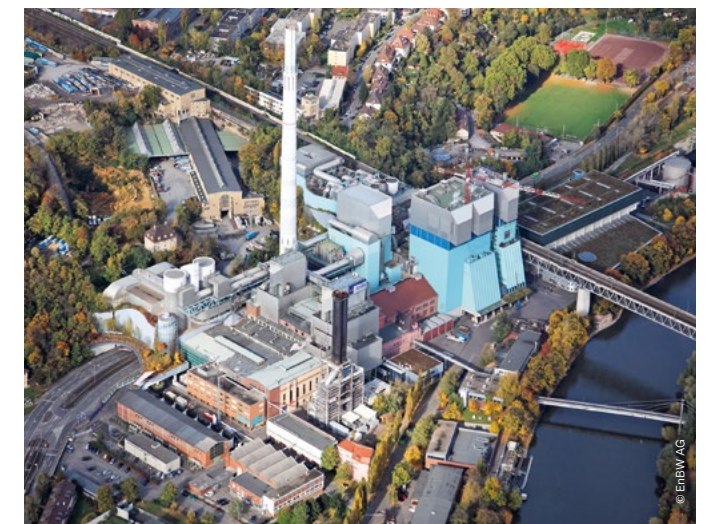
Gas- und Dampfkraftwerk in Stuttgart-Münster.
